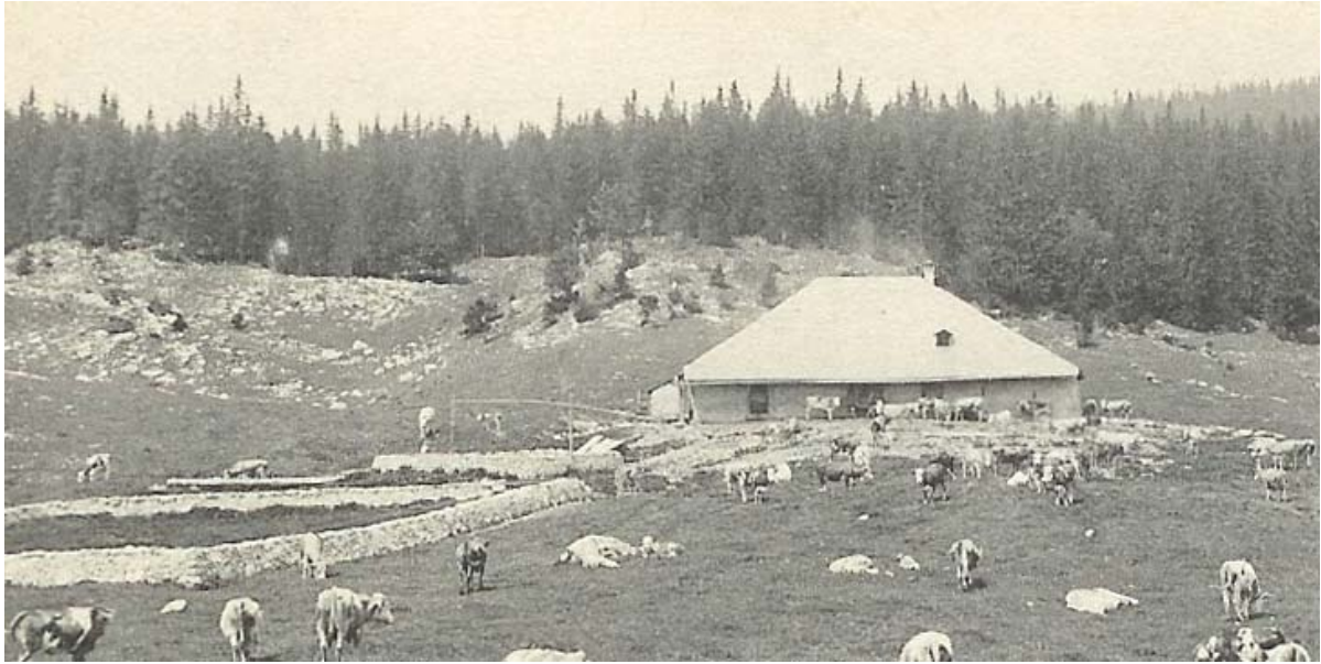
Chalet Vermeilley sur France. Les murs de pierre sèche encerclent ici, d'une part la citerne ou puits, et d'autre part le pré de fauche, ainsi qu'à peu près partout sur nos alpages.
